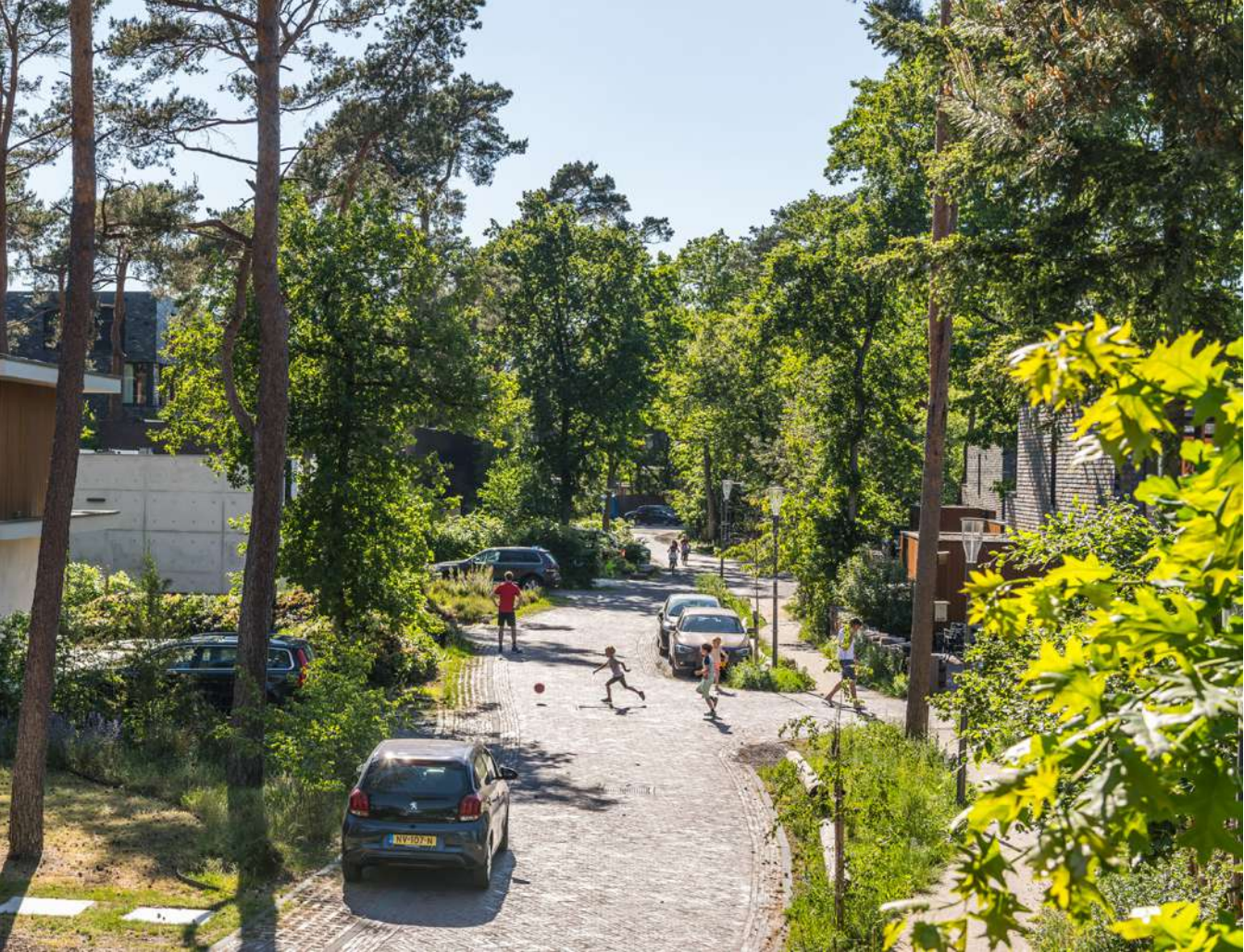
Parkbuurt Rotterdam als voorbeeld van het accentueren van landschappelijke structuren en elementen. Grote volwassen bomen waren samen met de stroken-opzet uit de naastgelegen wijk het uitgangspunt dat ECHO urban design heeft gebruikt om een eigentijdse structuur in de parkhoven te ontwerpen. (credits: ECHO Urban design, foto Joep van Aert)
